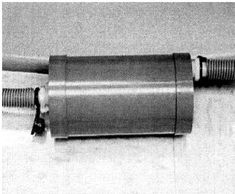
El filtro de amalgama que se muestra en la foto está instalado en un sillón. La unidad está colocada en el suelo al lado del sillón. Si el espacio lo permite, se puede colocar dentro de la caja de conexiones instalada en el suelo. Este filtro lleva los conectores de manguera de 15,9 mm con las tapas de vinilo rojas. En algunas instalaciones, se debe recolocar el sistema de aspiración fuera del sillón enganchándolo mediante cierres de velcro para mantenerlo lejos del suelo.
